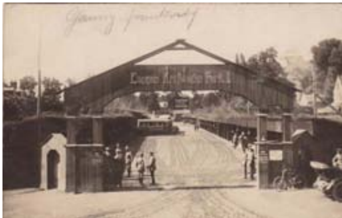
Eingangstor zum Etappen – Kraftwagenpark Nr. I 9
